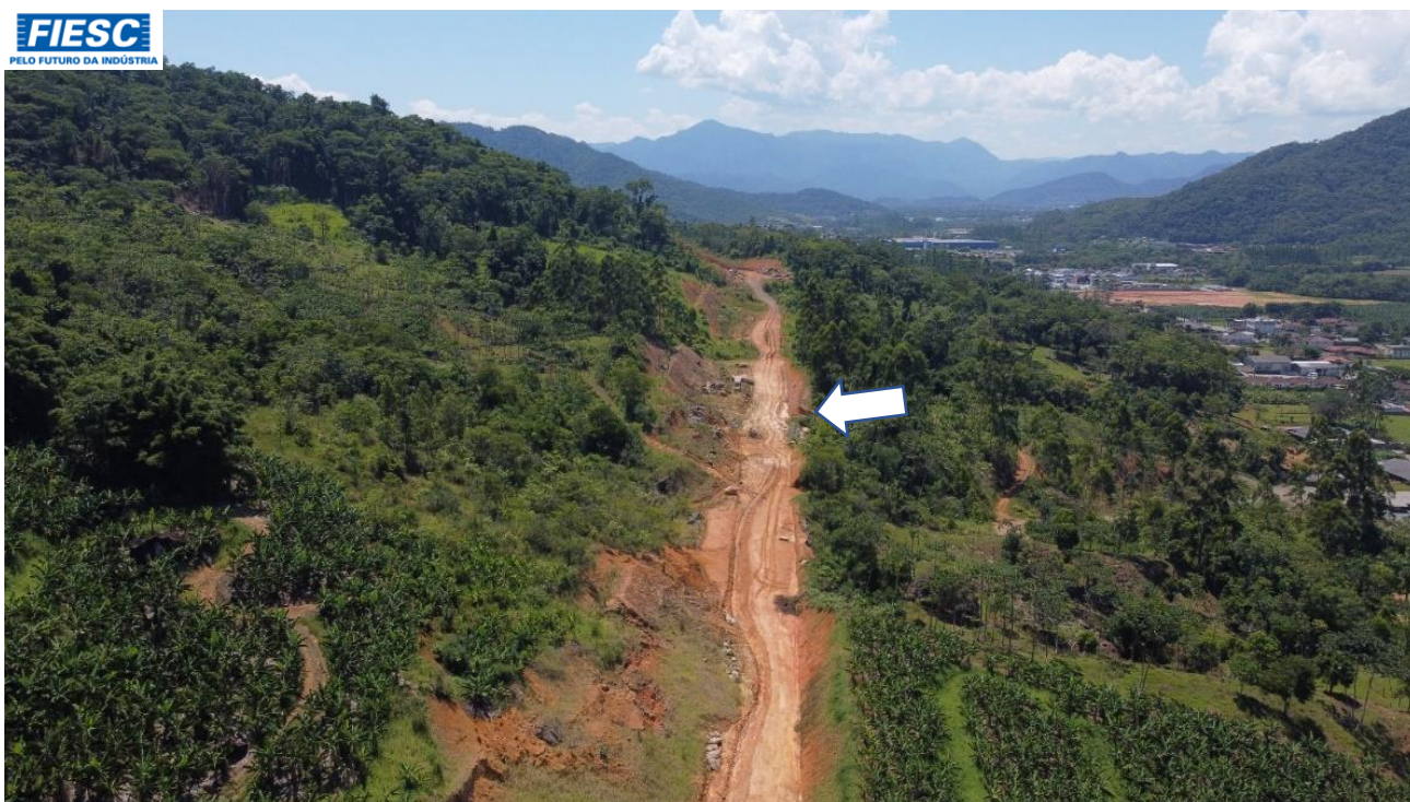
37: SEGMENTO EM IMPLANTAÇÃO ENTRE Km 60 E 66,0.
