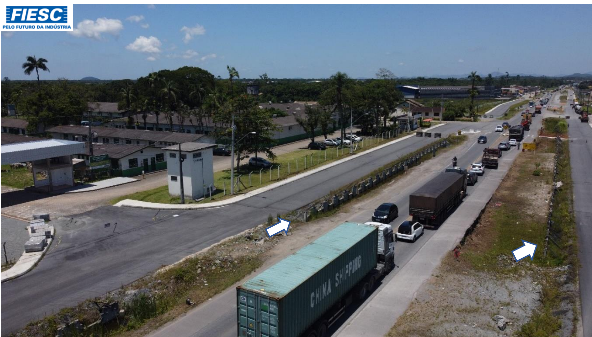
21: VIADUTO NO Km 26+986 - IFSC - ELEMENTOS DOS MUROS DE CONTENÇÕES EM TERRA ARMADA
