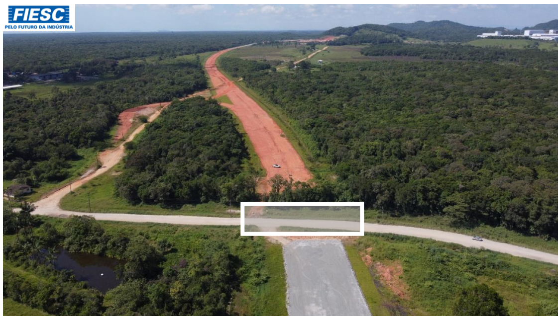
4: NOVO TRAÇADO ... Km 06+010 ... VIADUTO À SER CONSTRUÍDO
