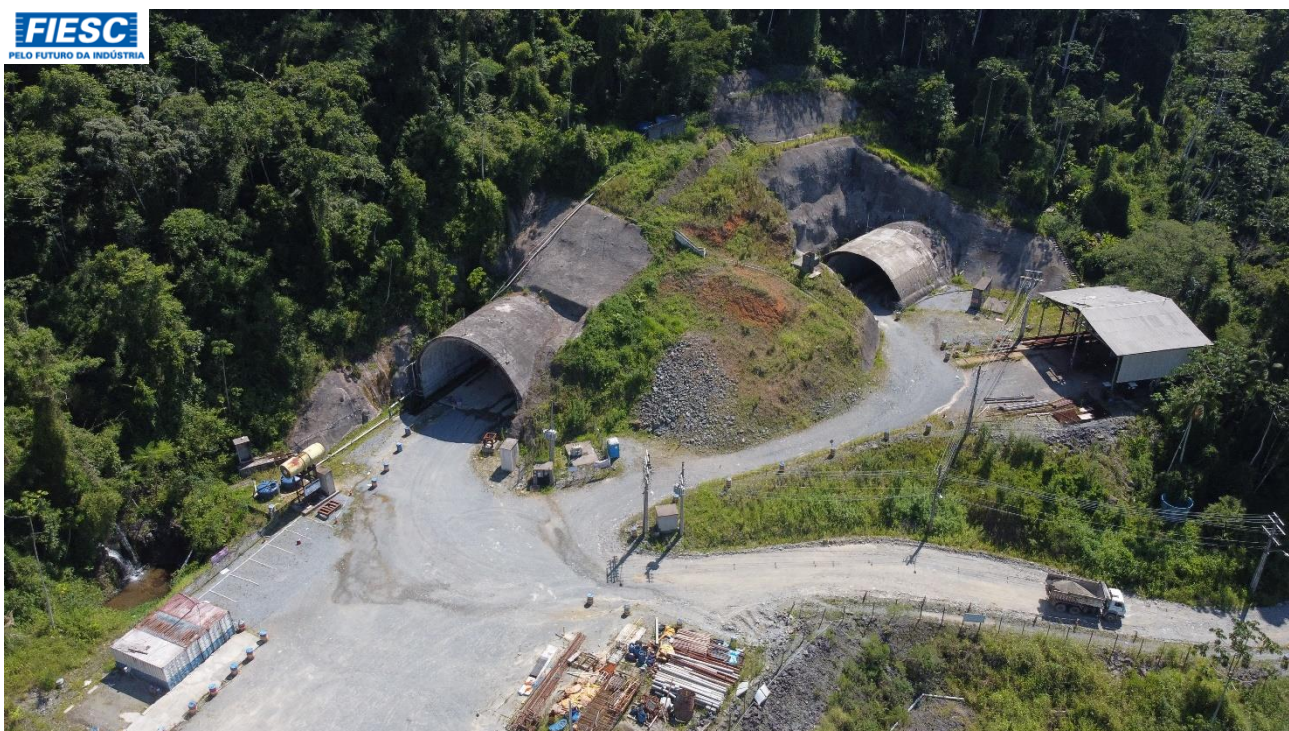
41: VISTA DO EMBOCAMENTO "A" DO TÚNEL, NO BAIRRO JOÃO PESSOA
