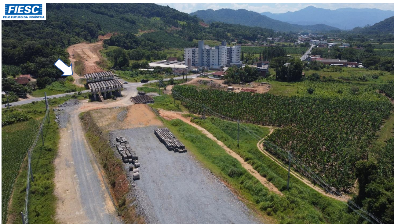
36: PASSAGEM SUPERIOR SOBRE A SC-108, EM SCHROEDER
