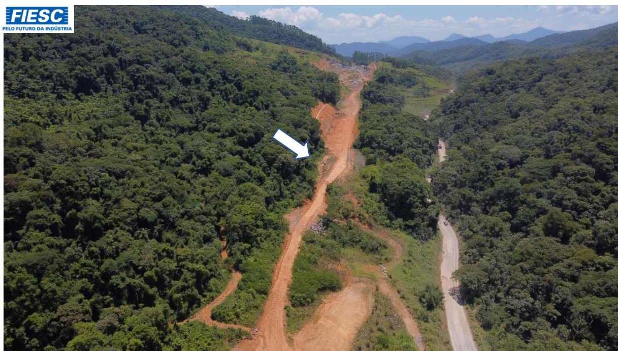
28: IMPLANTAÇÃO EM EXECUÇÃO ENTRE OS Km. 54,5 E 62,0
