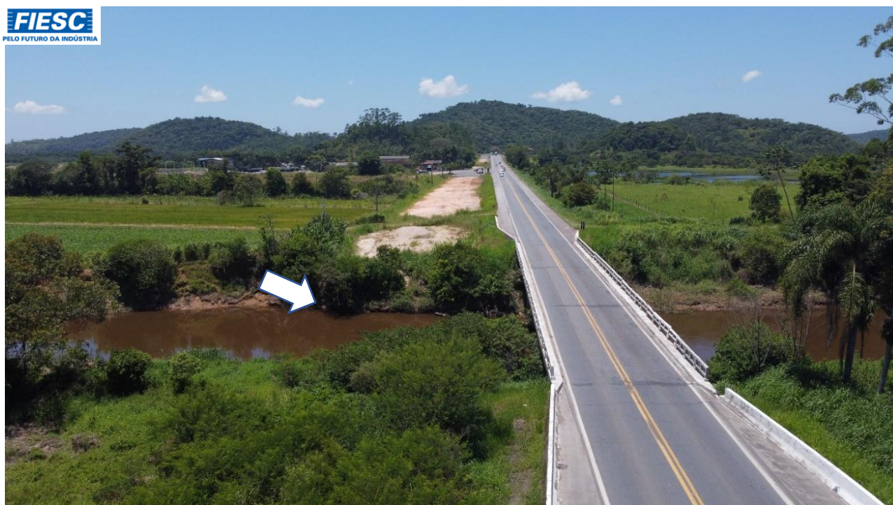
24: PONTE À SER CONSTRUÍDA SOBRE O RIO PIRAÍ - Km 38,8
