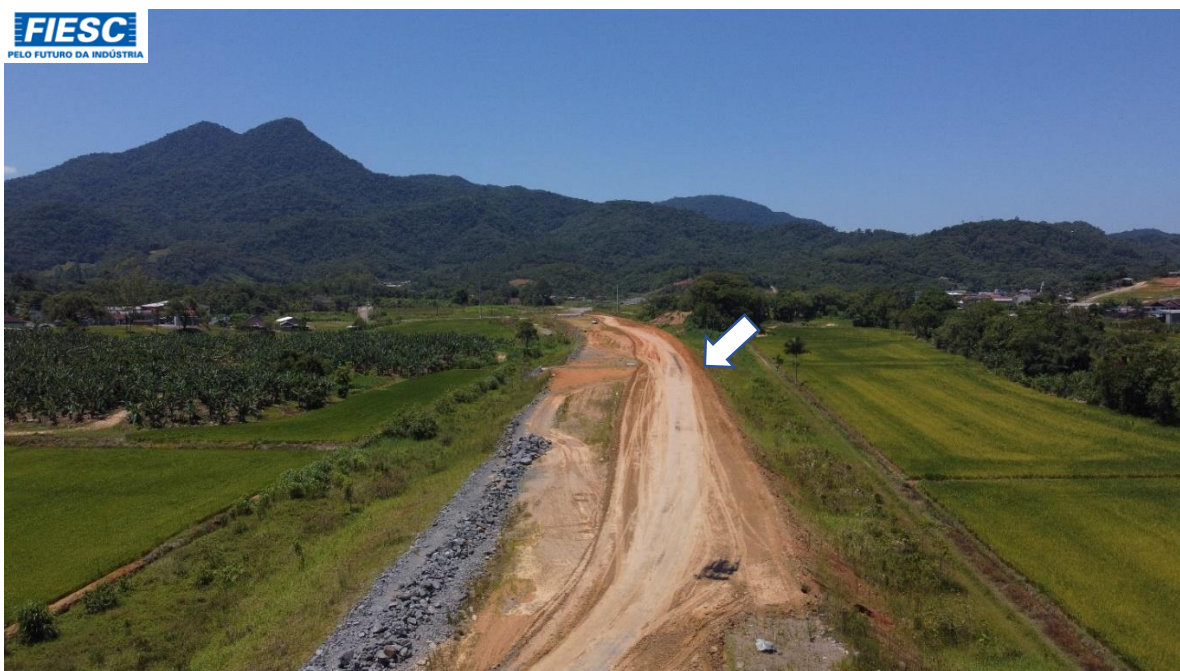
33: SEGMENTO EM IMPLANTAÇÃO NUMA EXTENSÃO APROXIMADA DE 700 M ... Km 60,0
