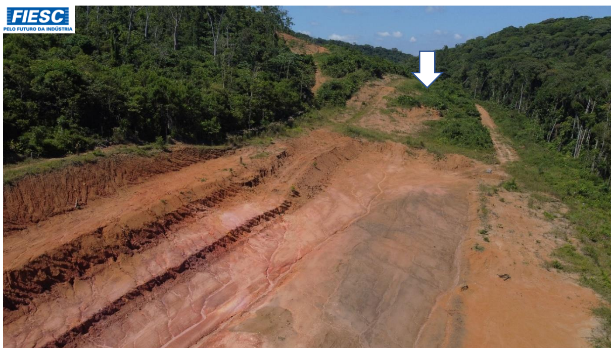
10: OUTRAS VISTAS REALÇANDO OS VOLUMES À SEREM TERRAPLENADOS
