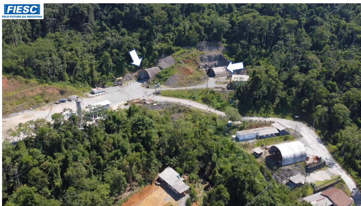
40: CANTEIRO DE OBRAS DA IMPLANTAÇÃO DO TÚNEL ENG. ANTONIO CARLOS BESSA
