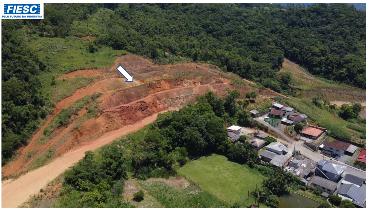
30: VISTA DO CORTE NO Km 57,2
