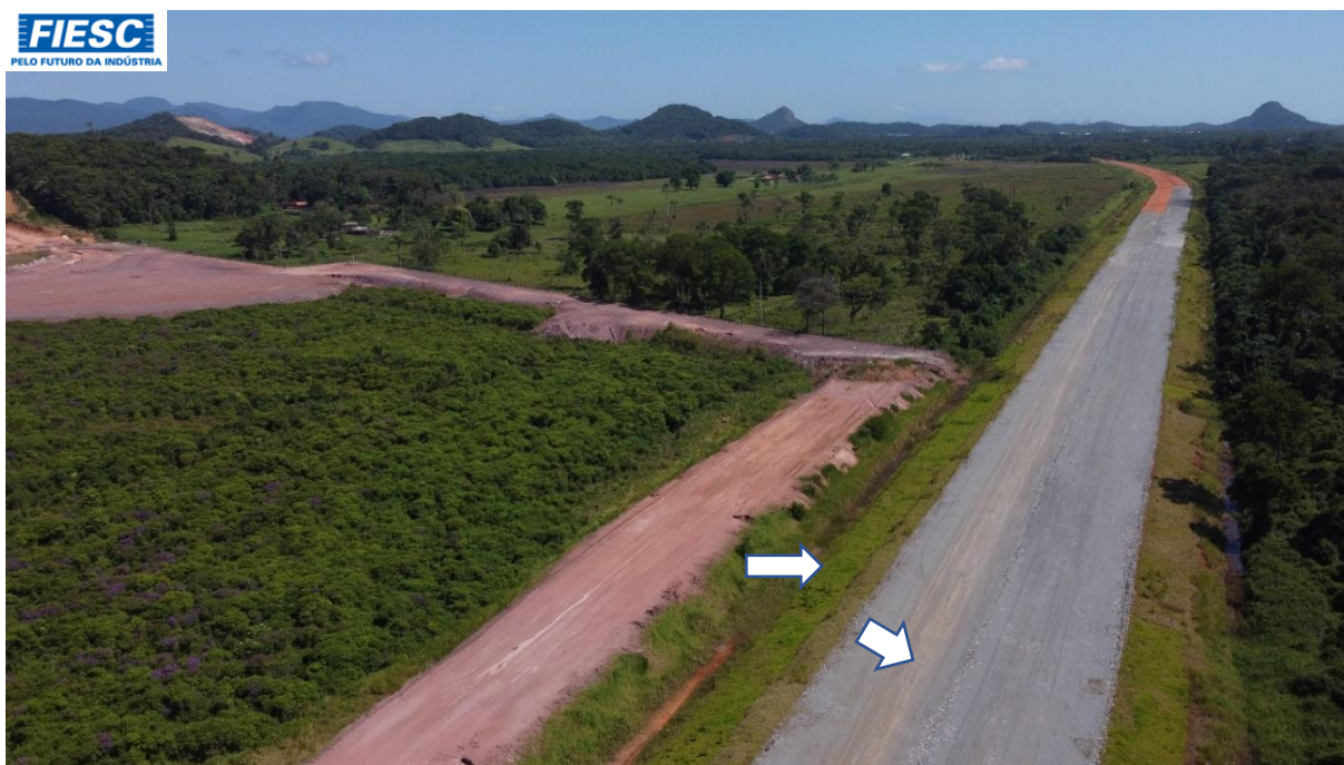
5: Km 8,50 ... BASE PAVIMENTO E ENLEIVAMENTO "SAIA" DO ATERRO EXECUTADOS
