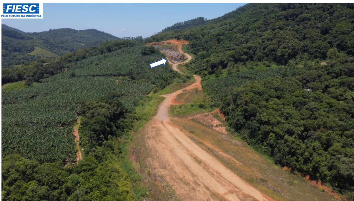
29: OUTRA VISTA DAS OBRAS DE IMPLANTAÇÃO
