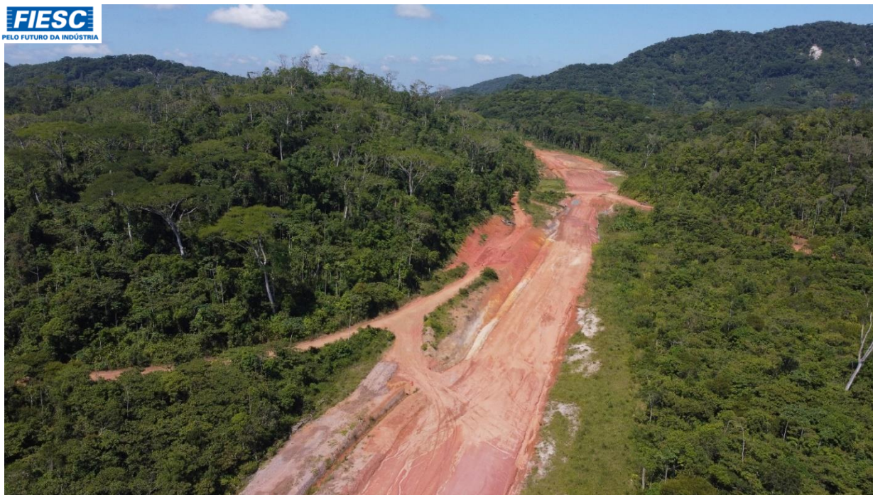
9: OUTRO SEGMENTO PRÓXIMO AO Km 10,7 EM IMPLANTAÇÃO
