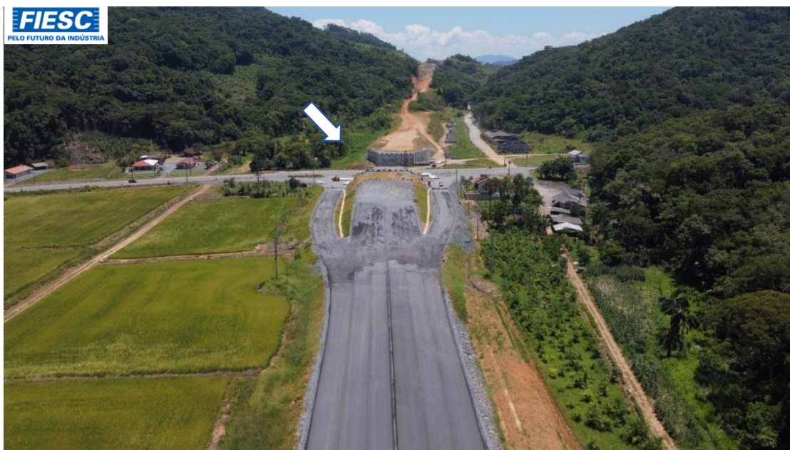
27: VIADUTO NO Km 54,0 SOBRE A SC-108
