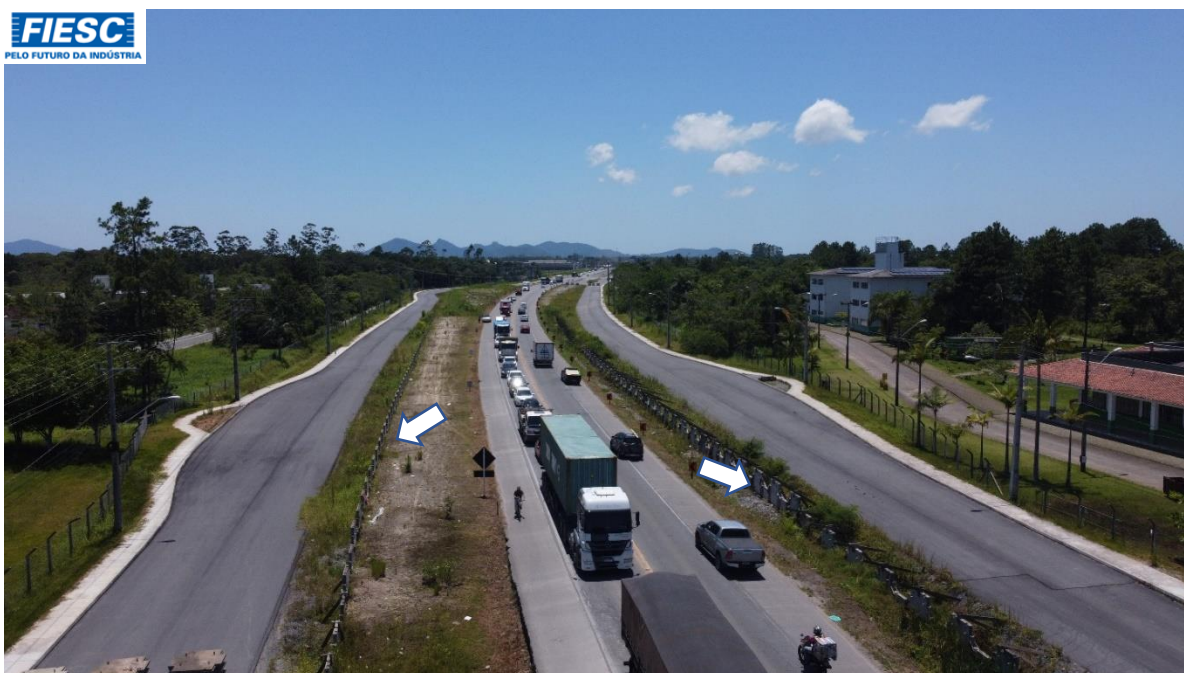
20: OUTRA VISTA DO MURO DE CONTENÇÕES INICIADO E ABANDONADO (Km 26+986)
