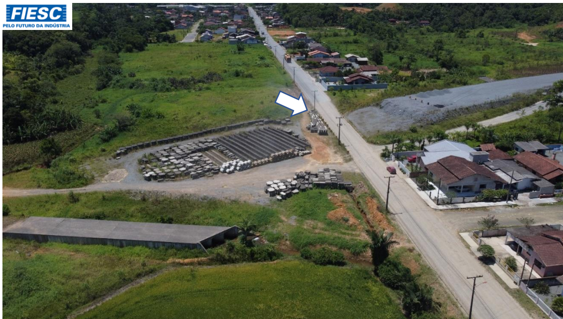
32: PASSAGEM SUPERIOR SOBRE A RUA RIO DE JANEIRO II (Km 59,60)
