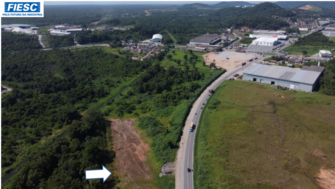
3: Km 03+ 840 - VIADUTO À SER CONSTRUÍDO - INÍCIO NOVA PISTA DUPLICAÇÃO
