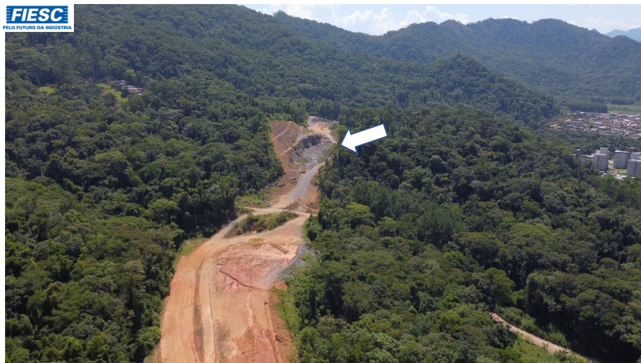
38: OBSERVA-SE O CORTE "CAIXÃO" EM ROCHA, NO SEGMENTO ACIMA
