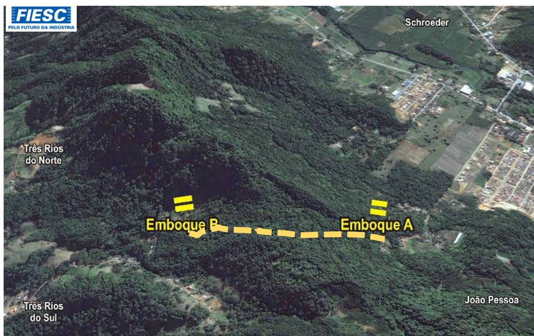
39: MORRO VIEIRA, EM JOÃO PESSOA - IMPLANTAÇÃO TÚNEL ENG. ANTONIO CARLOS BESSA, Km 66,0
