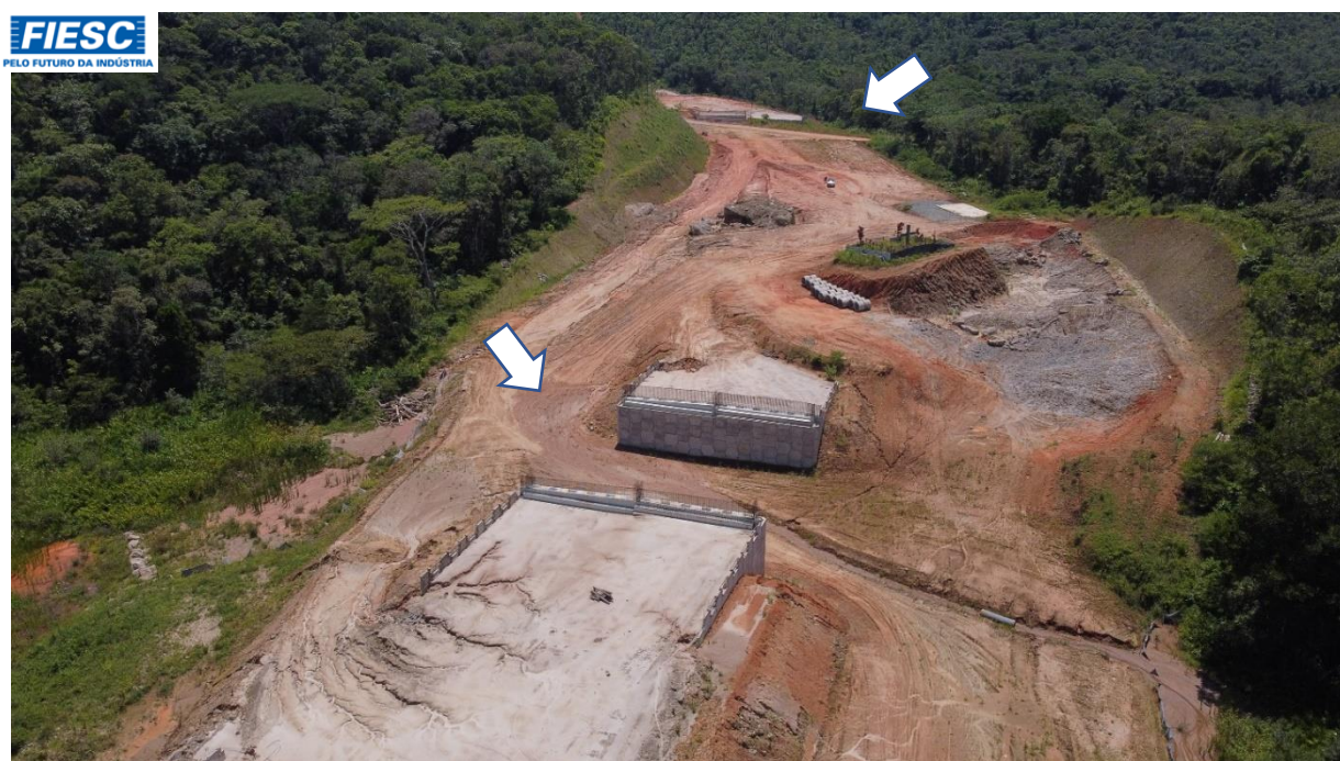
12: VIADUTO EM EXECUÇÃO NO Km 11+238 - NOVO TRAÇADO
